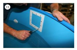
Den Skimmer mit Hilfe des Klemmflansches von innen mit den Flanschschrauben über Kreuz befestigen
