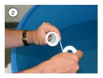
Alle Schraubverbindungen müssen mit Teflonband abgedichtet werden.
