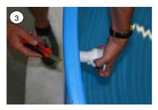
Eine Dichtung auf die Einlaufdüse setzen und diese von innen gegen die Folie durch das gestanzte Loch drücken
