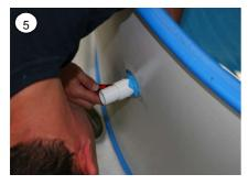
Anschließend die Düse durch das Loch schieben, und die überschüssige Folie abschneiden
