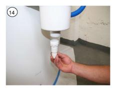
Die Schlauchtülle mit Teflonband abdichten und von unten in den Skimmer eindrehen
